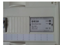
Virtalähde ja varmistus uPU: Asennetaan pääjakokaappiin
